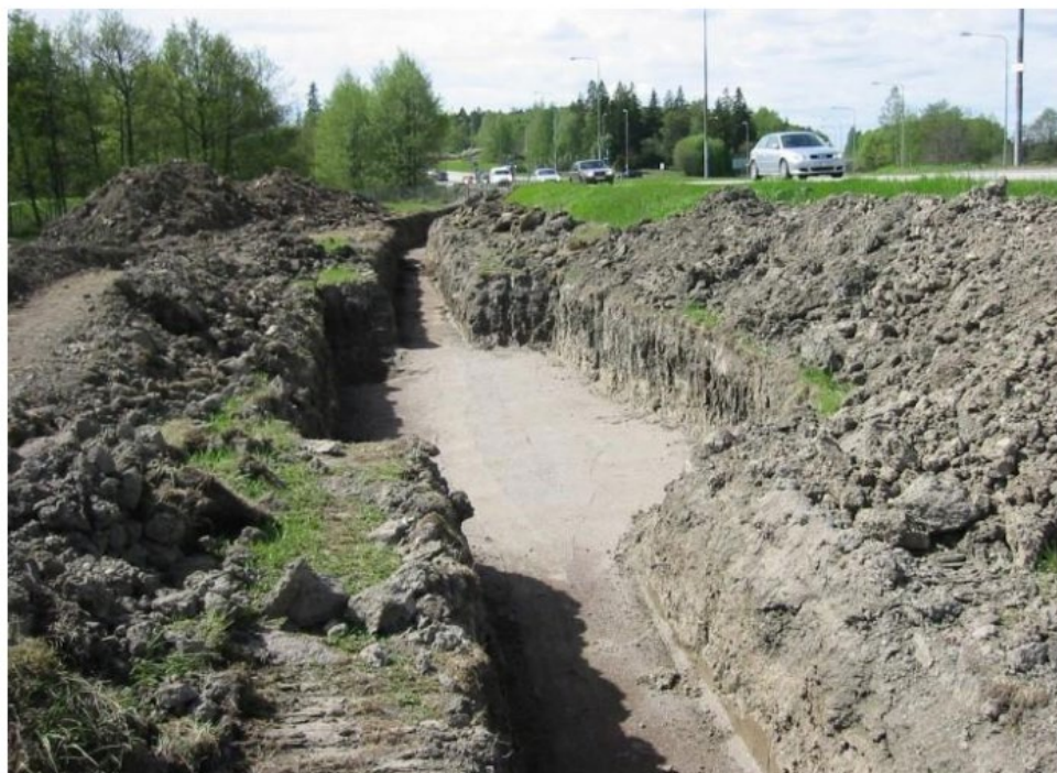
Figur 11. Exempel på utgrävning av schakt för skarvplats.
