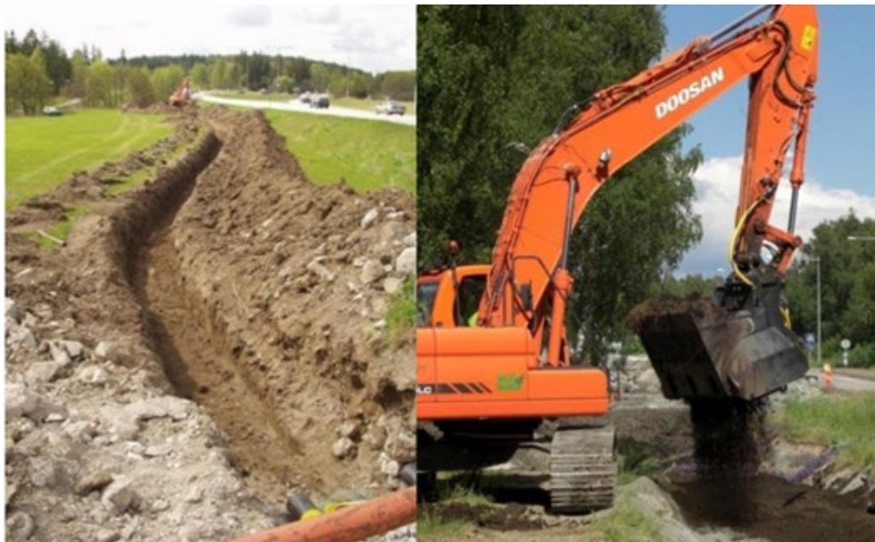
Figur 8. Exempel på kabelschakt och arbete med grävmaskin.
